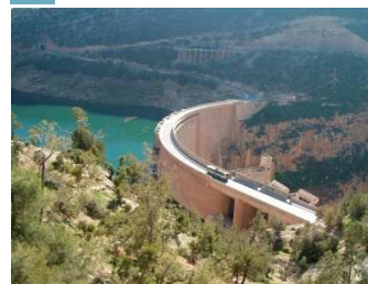
c Barrage de Bine el Ouidane (STEP Afourer)
