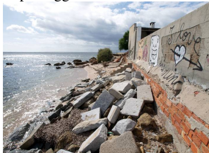
Torre Sant'Andrea, Quartu S.Elena (Ca): Al crollo di orribili manufatti moderni (in primo piano) si accompagna qui quello di una villa romana (sullo sfondo) (foto: E.Pranzini)
