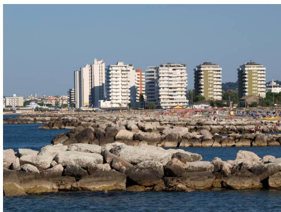
Misano Adriatico (RN): Un litorale un tempo sabbioso ed oggi trasformato in una distesa di massi (foto di E. Pranzini)
