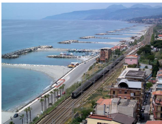
San Lucido (CS): La ferrovia, che per necessità venne costruita lungo le coste, è una delle cause dell'erosione delle spiagge e una delle infrastrutture più pesantemente difese. (foto: E.Pranzini)
