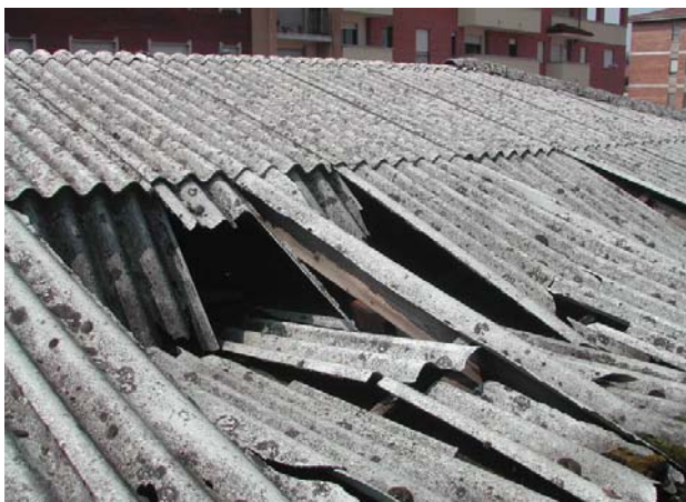
Le lastre scomposte e dirute su di un padiglione limitrofo la via Pontida
