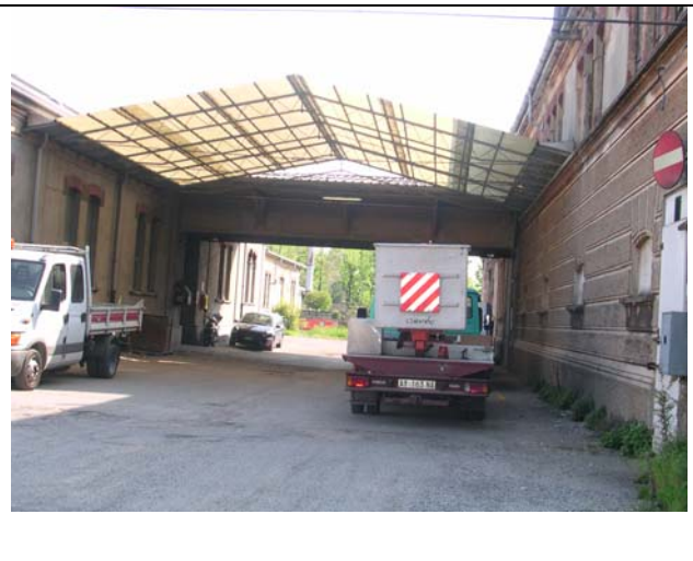
Padiglioni centrali. La pensilina di collegamento tra gli edifici
