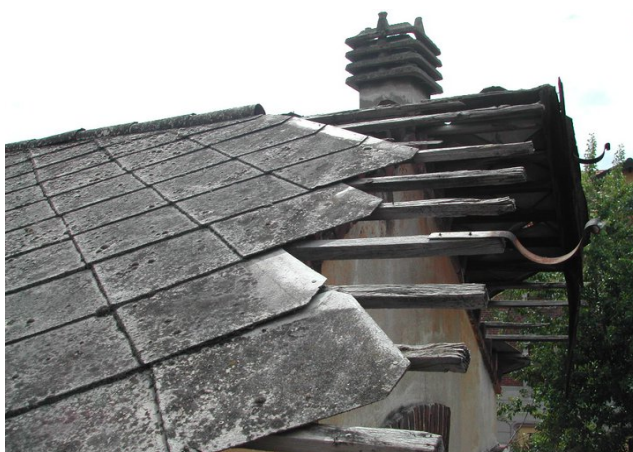
Particolare di una porzione di falda mancante
