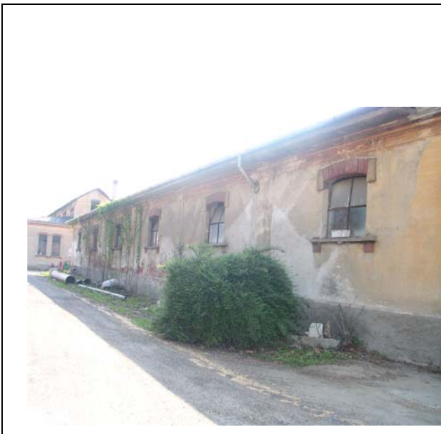
Fabbricato mono piano – padiglione laterale
