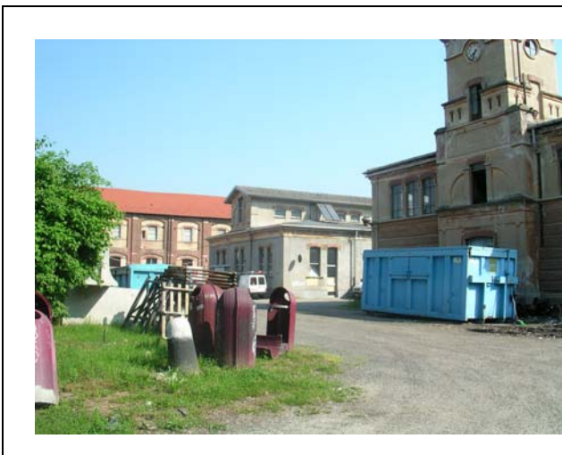
Scorcio dei due fabbricati del corpo centrale
