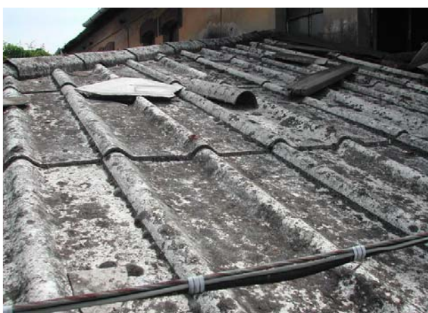
Copertura di un corpo basso di collegamento
