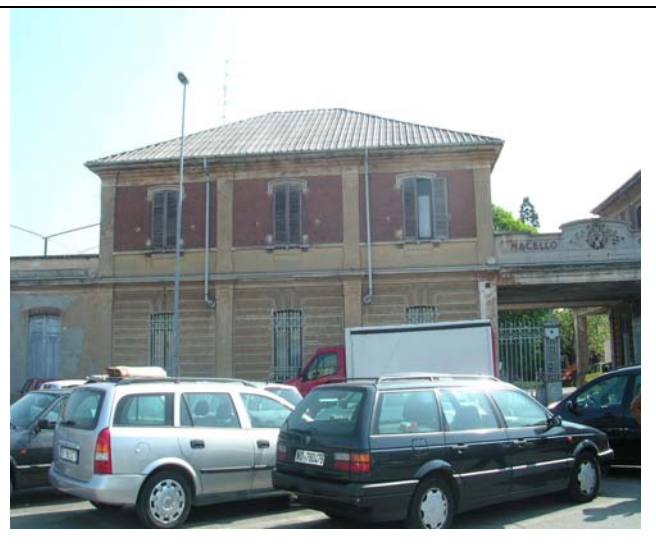
Palazzina lato sinistro d'ingresso da piazza Pasteur
