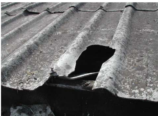
Diversa tipologia di lastra sempre con evidenti stati di degrado
