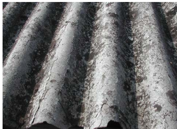
Particolare di una lastra con l'evidente processo di desfogliamento
